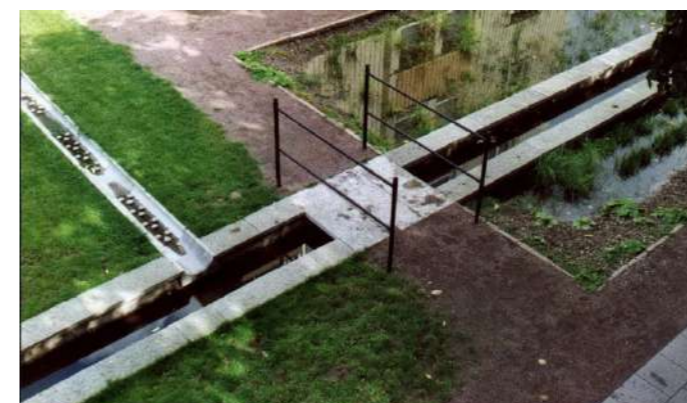
Figur 40: Ränna och kanal (Boverket 2023b)
